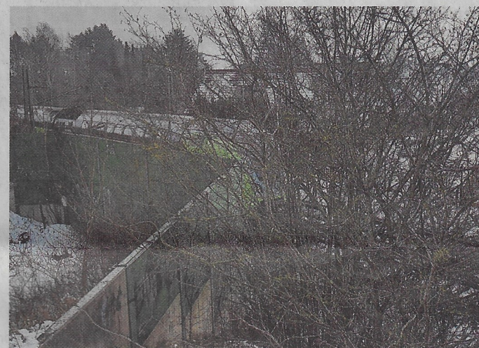
Die Bahnüberführung Rendsburger Straße wurde erst vor ein paar Jahren abgerissen. Hier könnte nun ein neuer Haltepunkt Richtung Flensburg entstehen.
