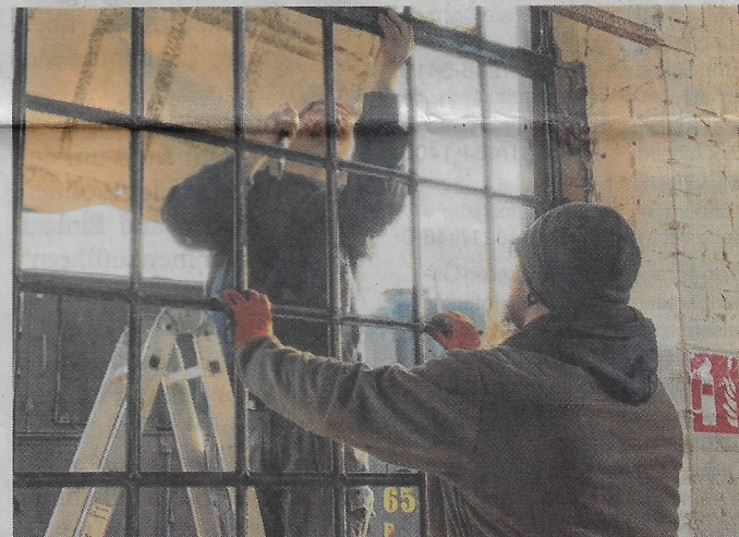
Mitarbeiter der Firma Bärenschmied restaurieren die eisernen Fensterrahmen.
