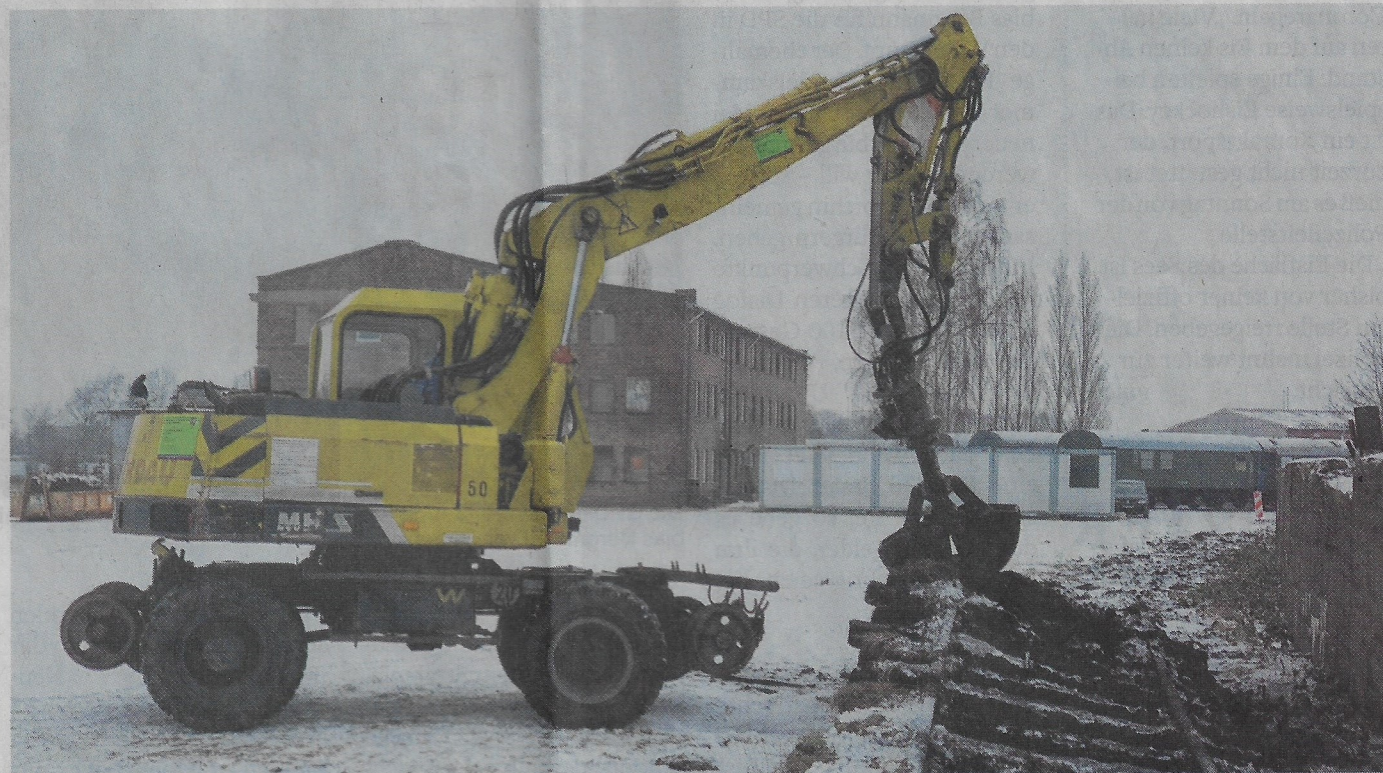
Auch bei Eis und Schnee wird am Gleis 65 gearbeitet.
