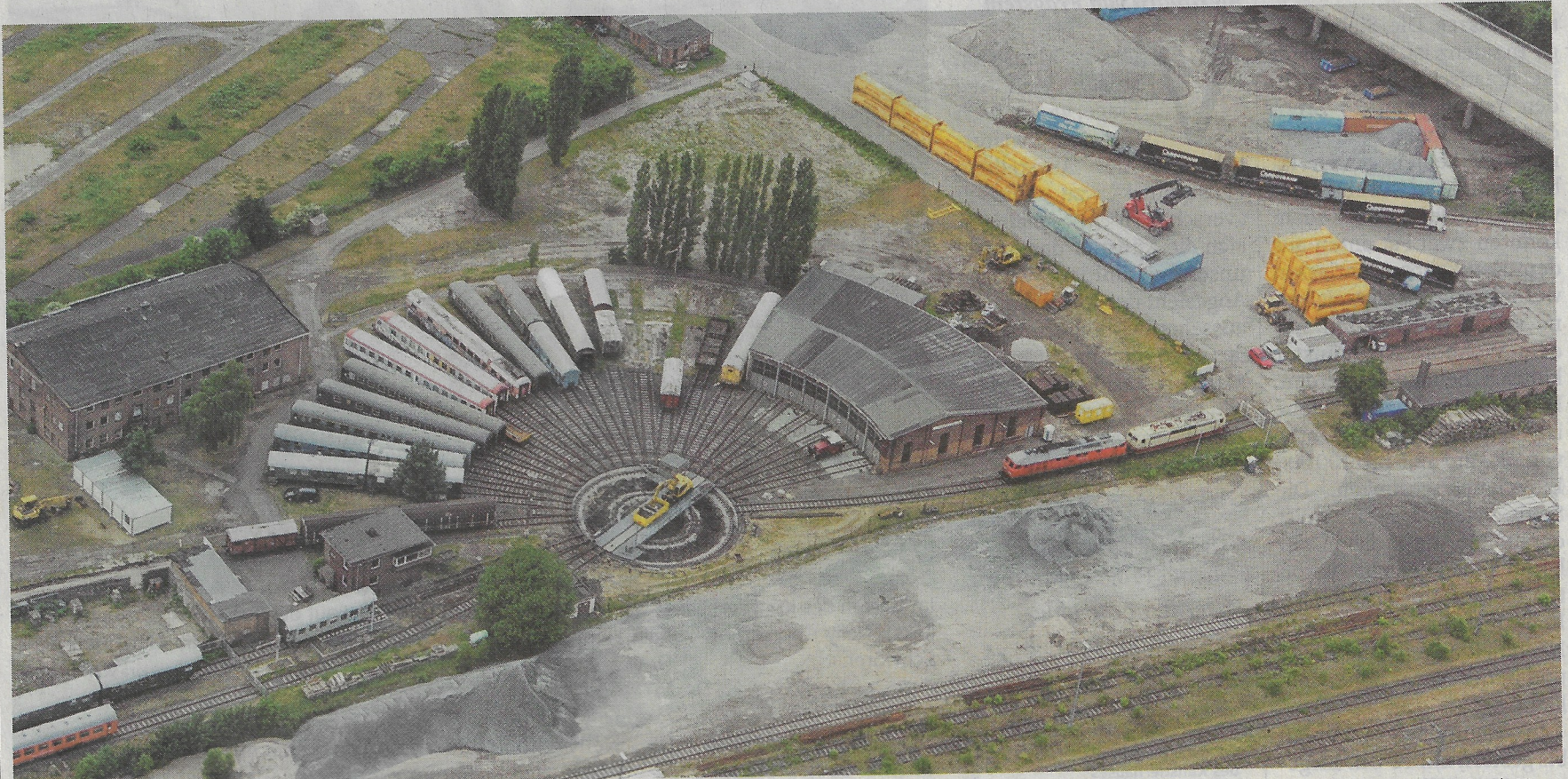
Am historischen Lokschuppen mit der Drehscheibe hat sich den vergangenen Monaten viel getan.
