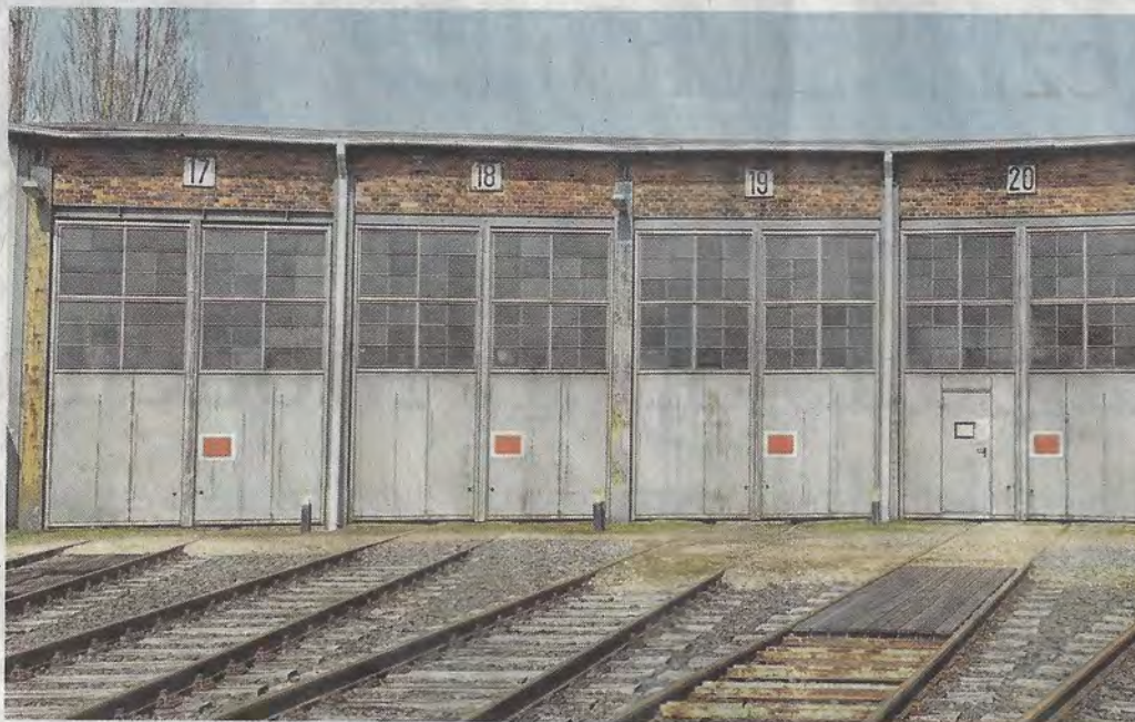
Am Lokschuppen sind rund 400 kaputte Glasscheiben erneuert worden.
